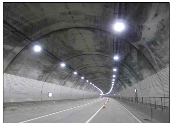
c. 터널 내부 전경
