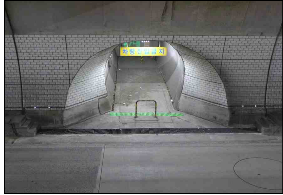
c. 피난연락갱(인도용) 전경(Span 93)
