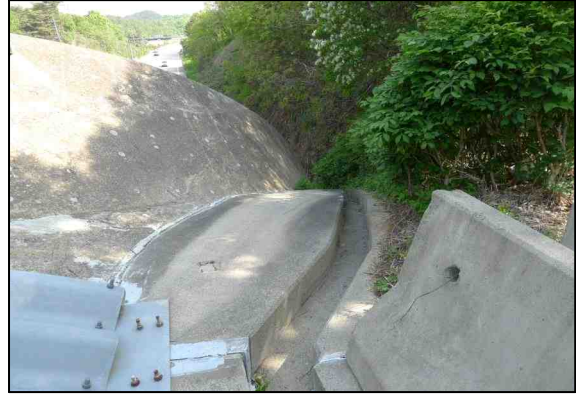
b. 종점 갱구부 배수로 전경
