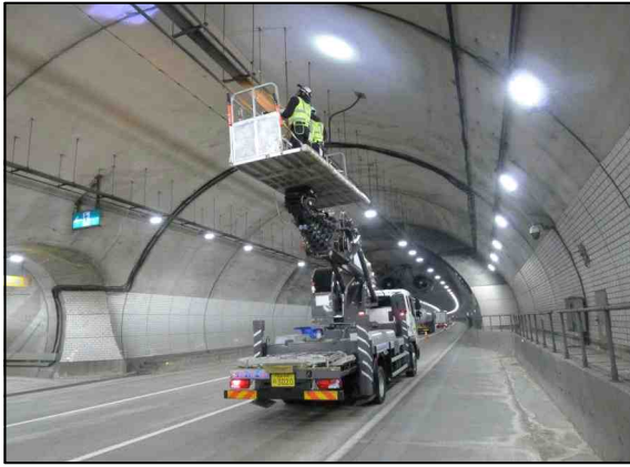
a. 고소작업차량을 이용한 천단부 외관조사현황①
