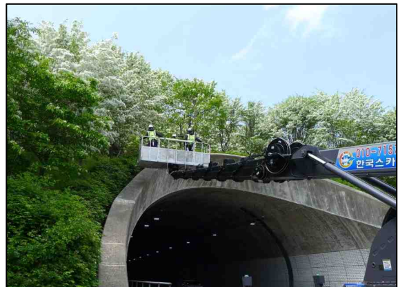
d. 고소작업차량을 이용한 갱구부 외관조사현황
