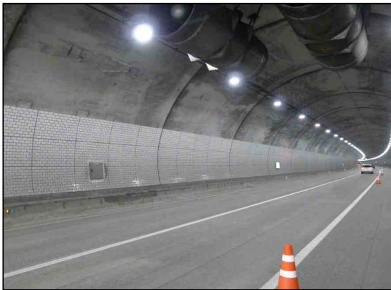
c. 콘크리트 라이닝(측벽부) 전경
