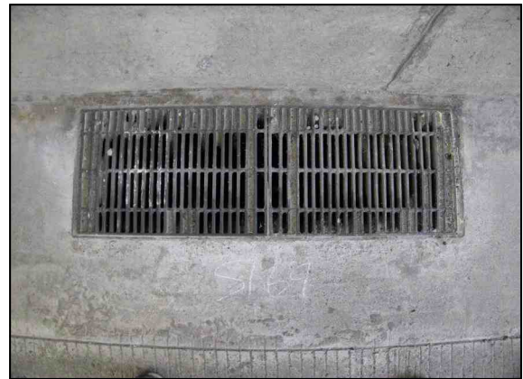
d. 배수시설 상태양호
