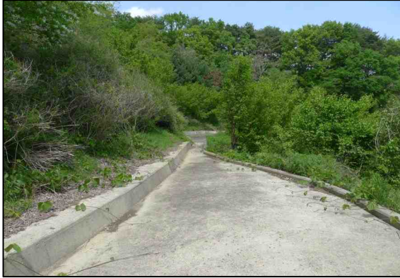
a. 시점 소단 배수로 전경
