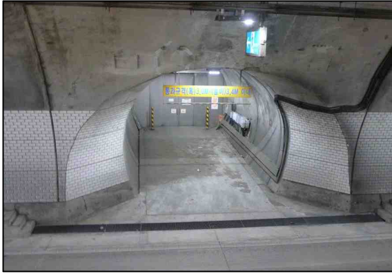
b. 피난연락갱(차량용) 전경(Span 56)
