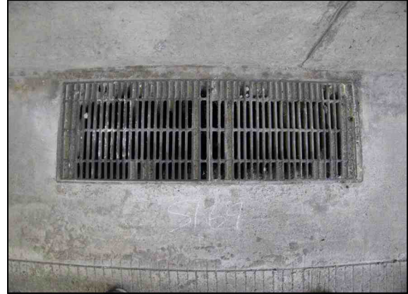
b. 배수시설 집수구 전경
