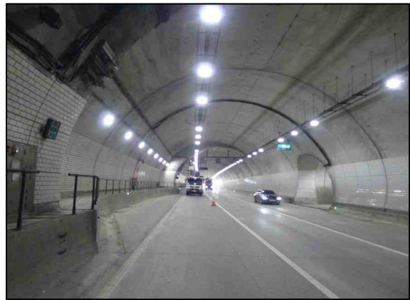
b. 단면변화부(Span. 128~132 비상주차대) 전경
