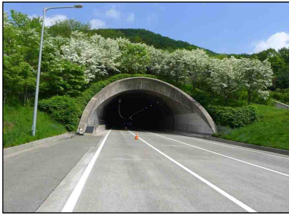
a. 시점부 갭문 상태양호
