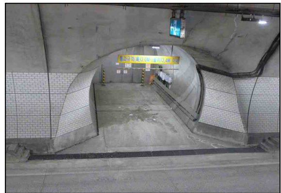
b. 피난연락갱 S130(차도용) 상태양호
