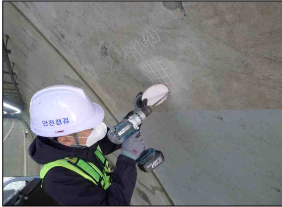
a. 탄산화시험부 부재 천공 현황
