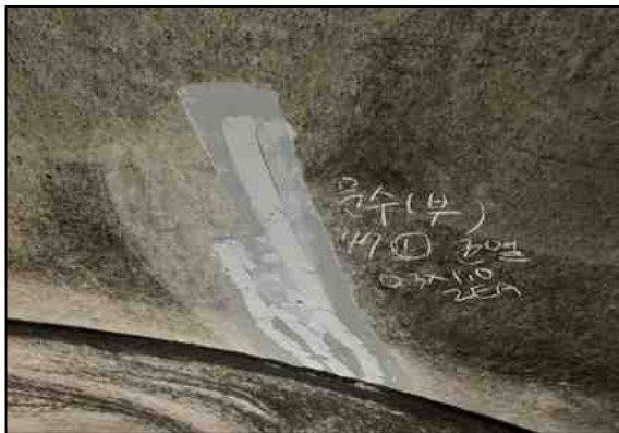
g. 천단부 S47 균열 보수현황
