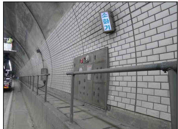
b. 공동구 상단 난간 설치현황
