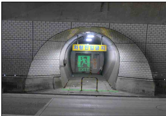
a. 피난연락갱 S93(인도용) 상태양호
