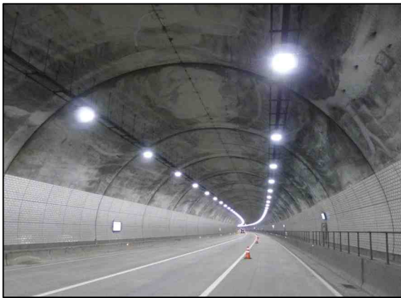
a. 콘크리트 라이닝(천단부) 전경
