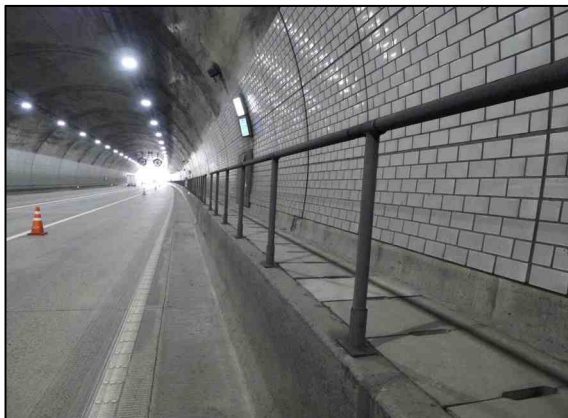
a. 공동구 상단 난간 전경
