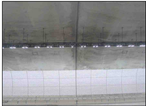
d. 측벽부 타일 시공현황
